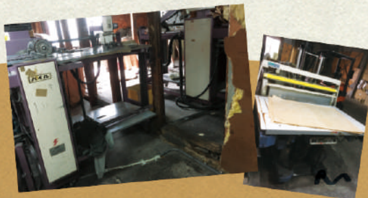
2019年12月解体作業開始
