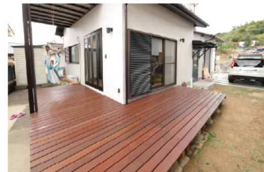
リビングと繋がるウッドデッキ。窓を開けると開放感抜群！子供たち も家で飽きたらすぐ外に出て、自由に遊ぶことができます。
