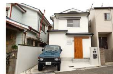
外部は塗装し直し、駐車スペース確保の為に減築を行い、さらに耐震工事も実施。
